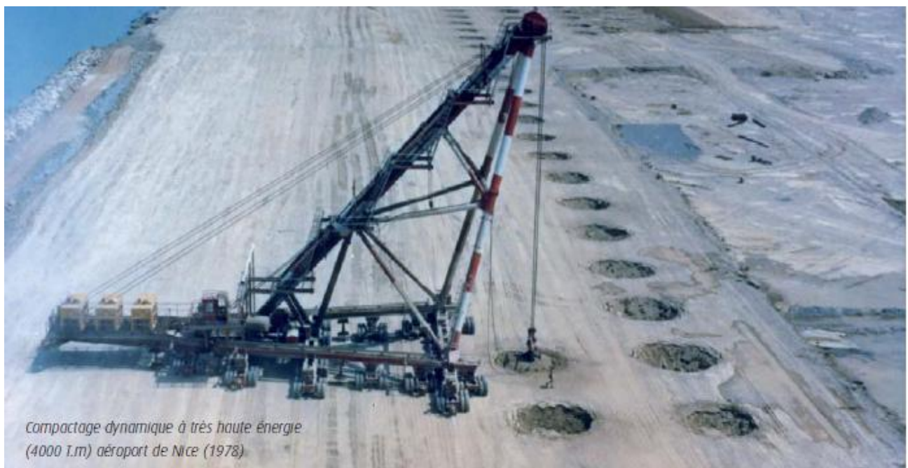
Figure 1 : Densification d'un terrain par compactage dynamique à très haute énergie (Cas réel de l'aéroport de Nice 1978, France).
